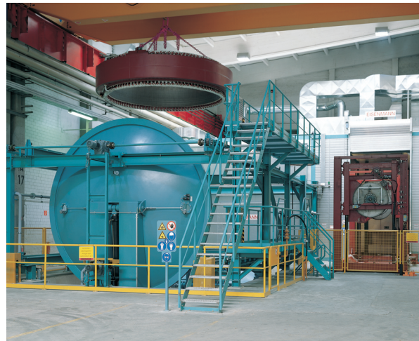
Abb.2: Großteile-Tränkanlage mit Kran-Beschickung
