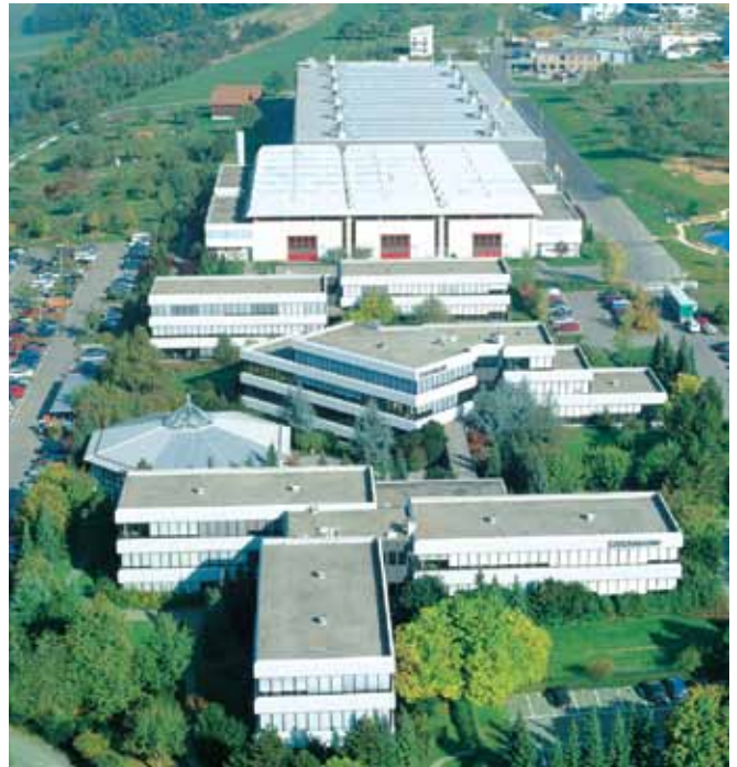
Eisenmann Technology Center in Holzgerlingen.
