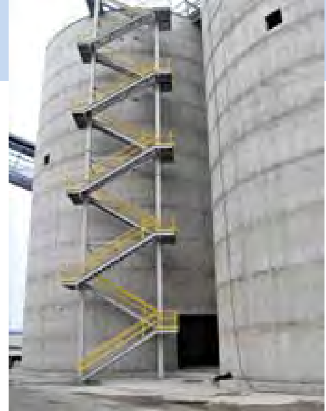
Silos de Hormigón Commonwealth diseñó y construyó estos dos (2) silos en hormigón armado, 30.5m de altura y 20m de diámetro, de almacenamiento de caliza para una empresa de servicios públicos en New Hampshire USA
