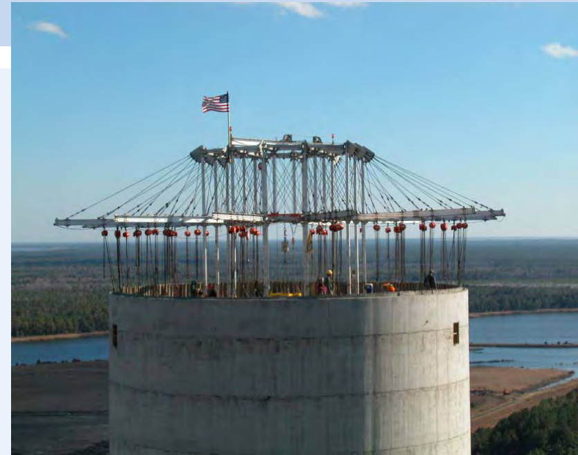
Fotografía de la parte superior de la chimenea de 124m de altura construida por el método de encofrado auto-trepante con dos líneas interiores de FRP para la plata Termoeléctrica Winyah localizada en Georgetown, SC.
