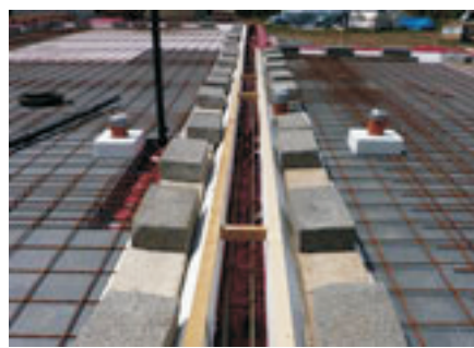
Pour concrete into Ringbeams
