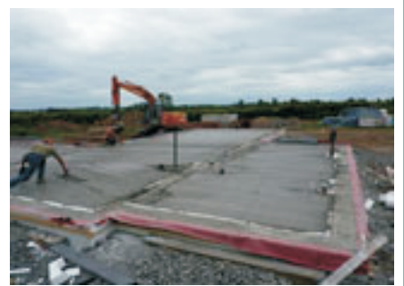
Pour the Concrete Floor
