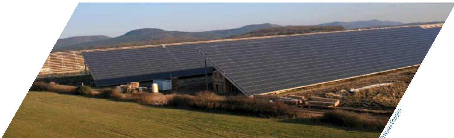
Une des plus grandes centrales photovoltaïques intégrée actuelle en France a été réalisée par un agriculteur sur 5 hangars de séchage (36 000 m<sup>2</sup> - 4,5 MW)
