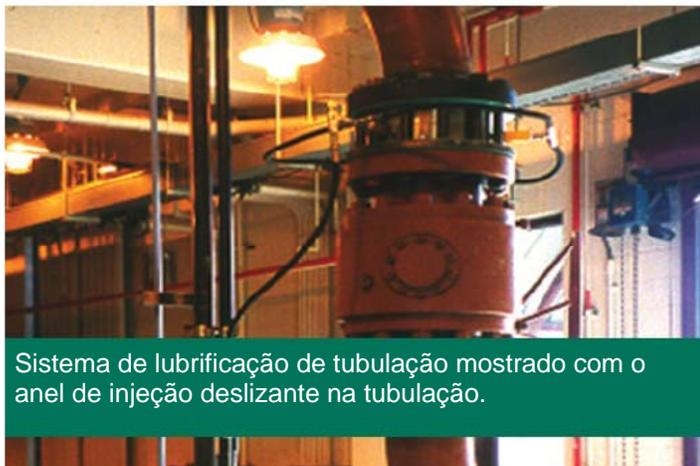
Sistema de lubrificação de tubulação mostrado com o anel de injeção deslizante na tubulação.
