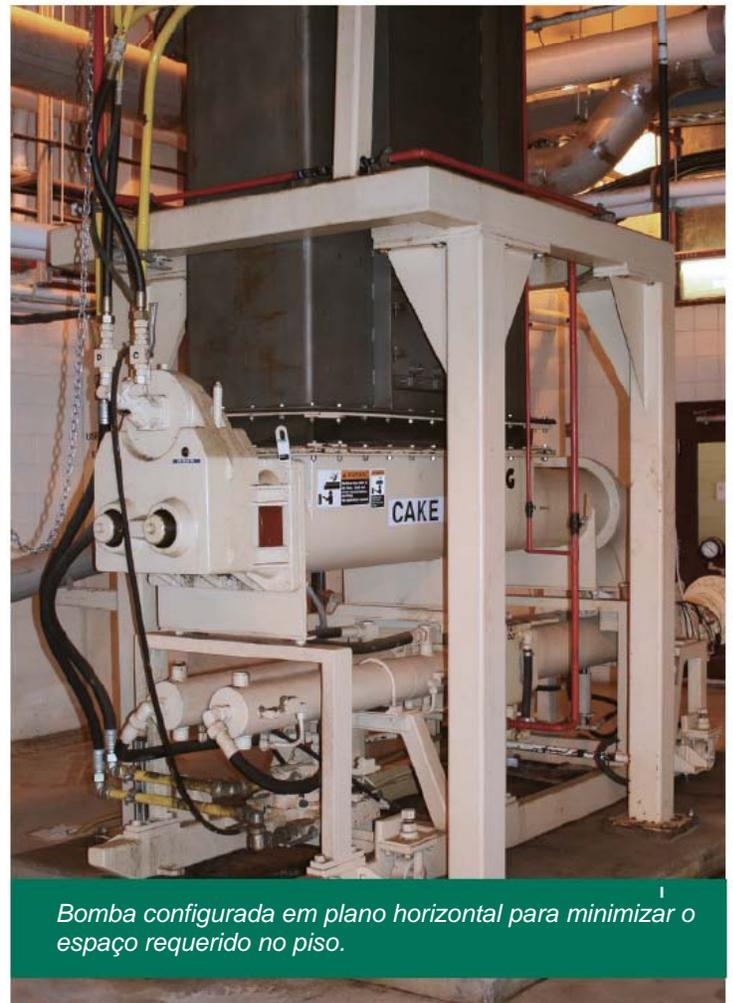
*Bomba configurada em plano horizontal para minimizar o espaço requerido no piso.*
