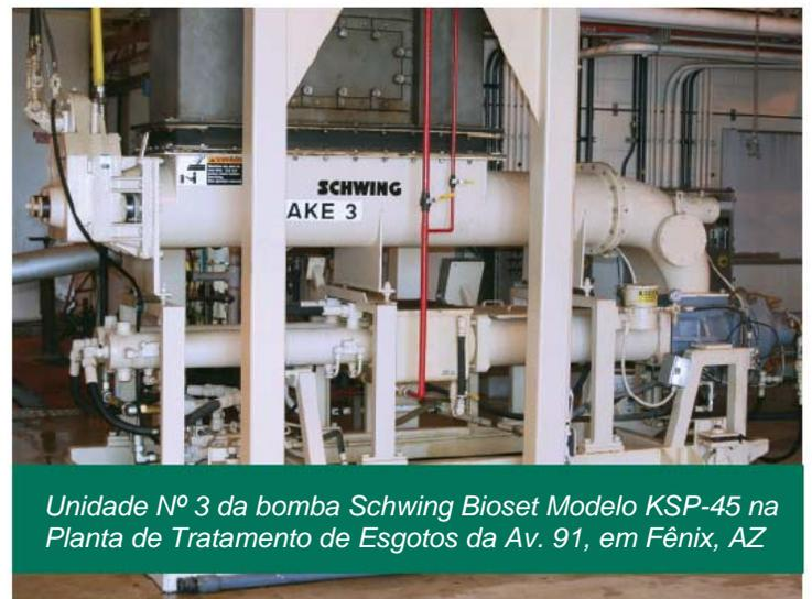
*Unidade Nº 3 da bomba Schwing Bioset Modelo KSP-45 na Planta de Tratamento de Esgotos da Av. 91, em Fênix, AZ*
