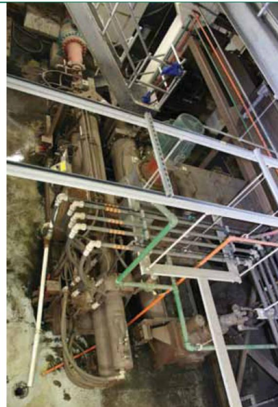
*O modelo KSP 110 V(HD)L da Schwing Bioset bombeia massa por mais de 500 pés até a Instalação Central de Descarga 110V(HD)L*
