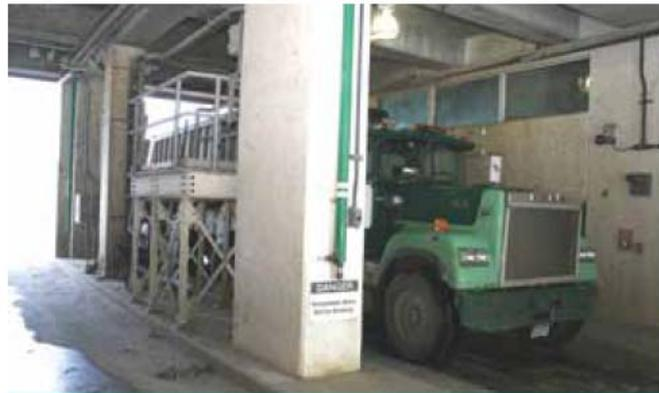
*O funil de carga de caminhões Schwing Bioset carrega biossólidos desaguados para transporte ao aterro.*
