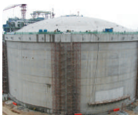
LNG storage tank Insulation
