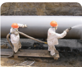
LNG pipe anticorrosive coating
