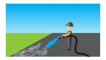
Aplique agua sobre la superficie a curar con la manguera de alto volumen para la hidratación inicial de la losa. Se recomienda 1/8 "-1/4".
