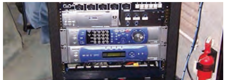
Atlas Rack Loaded with AV Equipment
