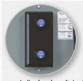
**2** **Indicador de voltaje:** Permite verificar visiblemente que se haya desconectado el voltaje sin necesidad de abrir la puerta
