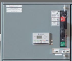
**Las unidades SecureConnect** permiten a los usuarios desconectar la alimentación eléctrica de una unidad MCC enchufable sin necesidad de abrir la puerta del envoltente.
