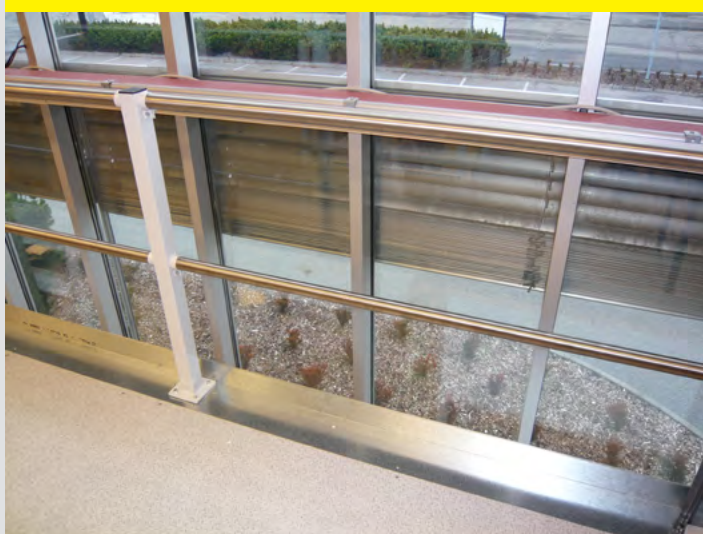
Som en kvalitetsfokuset aktør valgte selvsagt Heli-One å ivareta alle sikkerhetskrav med blant annet vaskbart og sklisikkert gulv, rekkverk foran vindu samt sparkelister rundt hele mesaninen
