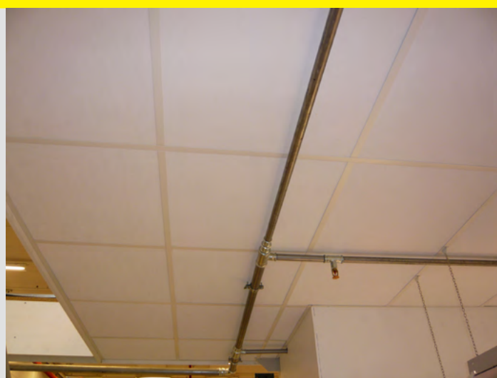
Mellom primær og sekundærdragere er det lagt himling for støyreduksjon. Nødvendig sprinkling lagt opp
