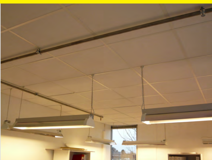
Mellom primær og sekundærdragere er det lagt himling for støyreduksjon. Nødvendig sprinkling lagt opp
