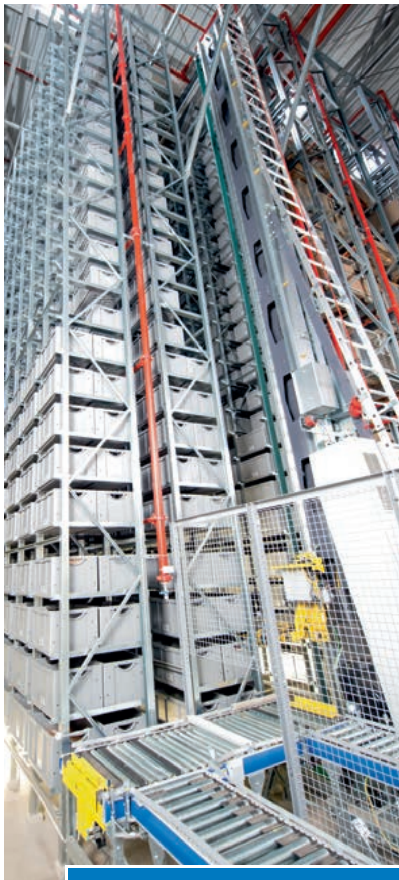
Automatisk smådelslager med rundt 15 500 beholderlokasjoner for alle smådeler med hurtig og middels omløp.
