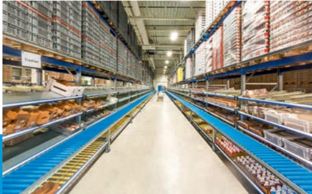
Plukkegate i kjøleområdet med 2 500 kanaler og forinstallert rullebane for beholdere. Gjennomløpsreolen for smådeler er integrert i pallereolen PR 600.
