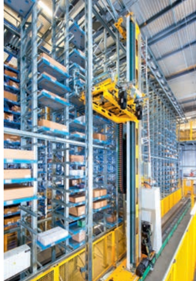
Innlegging av transportbrett i Mercury-systemet.
