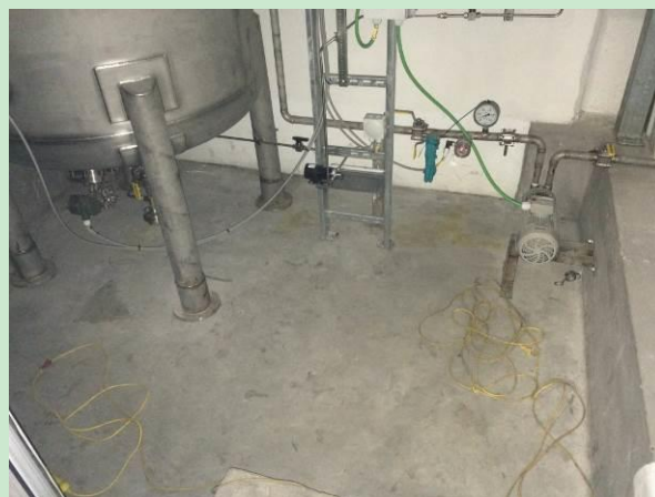
图 8.1-2 氨水储罐围堰
