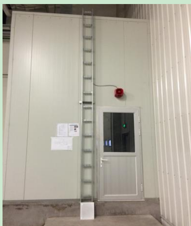
图 8.1-1 氨水储存房间
