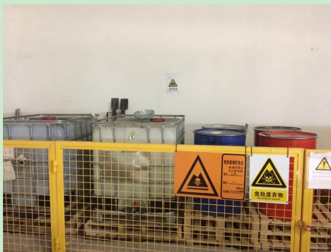
图 10.4-3 危险废物库房
