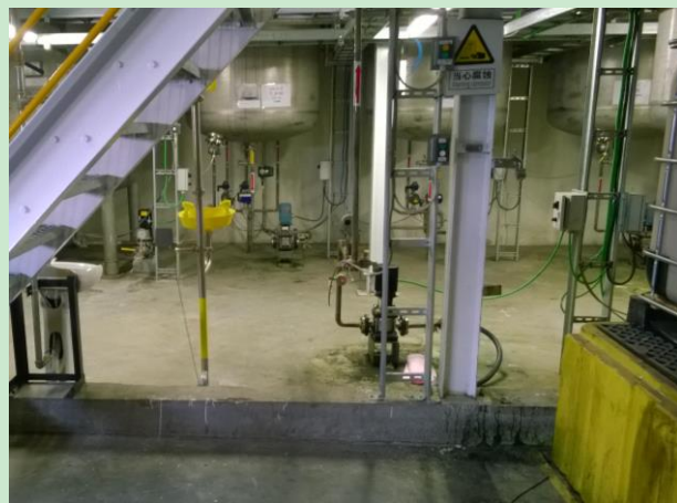
图 8.2-1 储罐区及围堰
