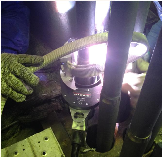
Dieser Maschinentyp kann zum Schweißen von Schwarzstahl und Edelstahl eingesetzt werden.
