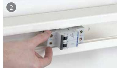
2 Clipar el conjunto en el envoltente o en la canal portamecanismos.
