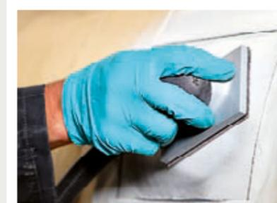
Aplane la imprimación de gran espesor con la tira Abranet® de Mirka, P 320 o P 400.
