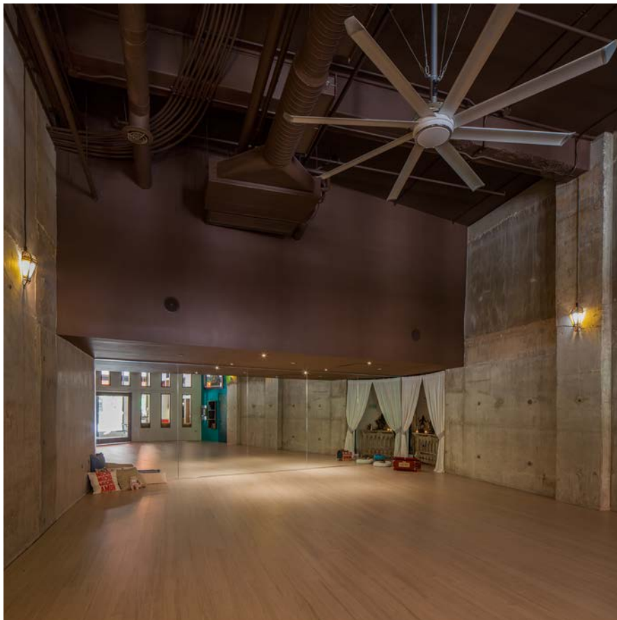
Big Ass Fans modelo Essence, aspas de construcción aluminio (8 a 14 ft de Diámetro) con "winglets" extendidos en color gris y centro en color blanco
