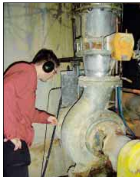
Med hjälp av noggranna pumpanalyser kan man spara betydliga mängder el vid processindustrin stora pumpningar.
