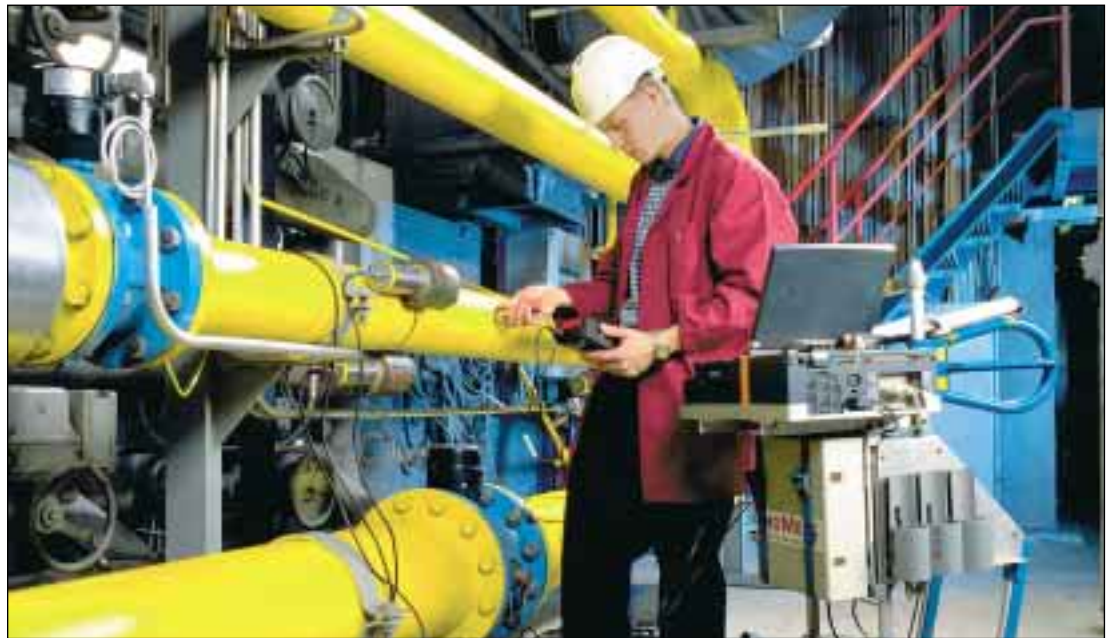
Fältkalibrering av en naturgasflödesmätning pågår. Flödets referensvärde erhålls från gasens medelhastighet i röret. Den uppmäts med pulser av radioaktiv gas som injiceras in i gasledningen.
