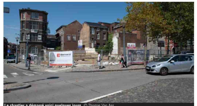
Le chantier a démarré voici quelques jours. © Thomas Van Ass
