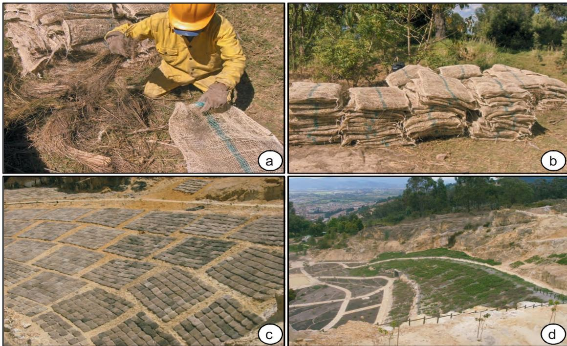
**Figura 7.9** a) b) y c) Elaboración de biomantos (Fotos: SDA-Unión Temporal JC, 2005), d) biomantos en el año 2009 en la Cantera Soratama.
