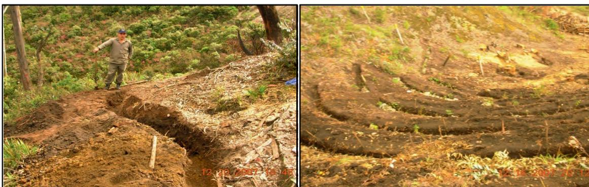
**Figura 7.48** Construcción de las banquetas de infiltración en la quebrada Hoya del Ramo (Fotos: Coopbogotá, 2007).
