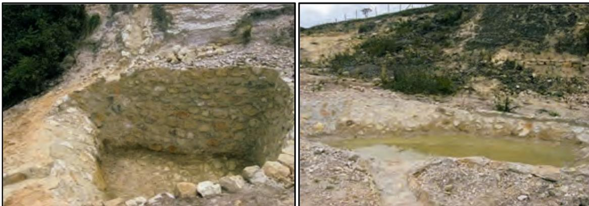
**Figura 7.6** Pocetas para el almacenamiento del agua (Fotos: SDA-Unión Temporal JC, 2005).
