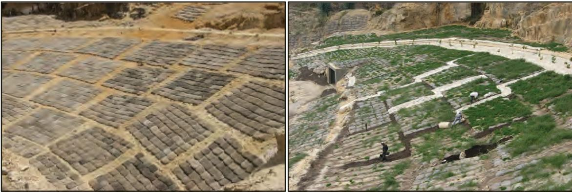
**Figura 6.18** Biomantos artesanales instalados sobre taludes en el Aula Ambiental Soratama.
