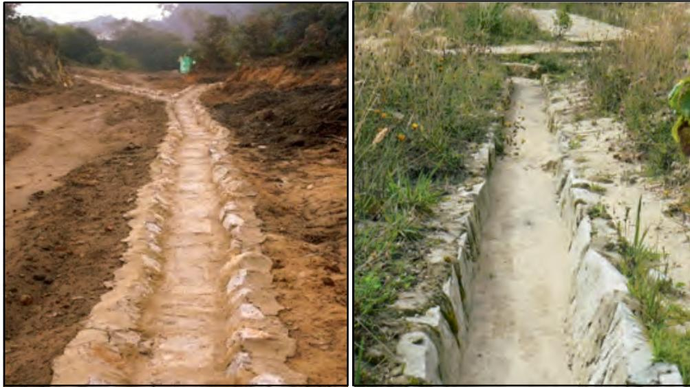
**Figura 7.5** Sistema de cunetas para regular, encausar y evacuar las aguas lluvias (2005) (Fotos: SDA-Unión Temporal JC, 2005; ERE-PUJ, 2010; SDA, 2009).
