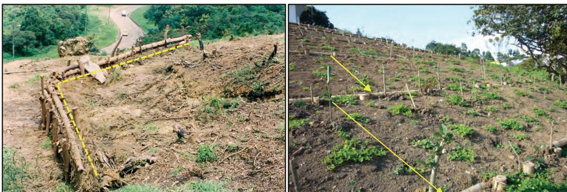
**Figura 6.14** Terrazas vivas. a). Imagen de terrazas construidas para el control de los procesos de erosión en Monserrate, Bogotá (Barrera, 1999). b). Terrazas escalonadas empotradas a una profundidad de cuatro (4) metros, ubicadas en el corregimiento de Dapa, Yumbo, Valle del Cauca (CIPAV, 2010).
