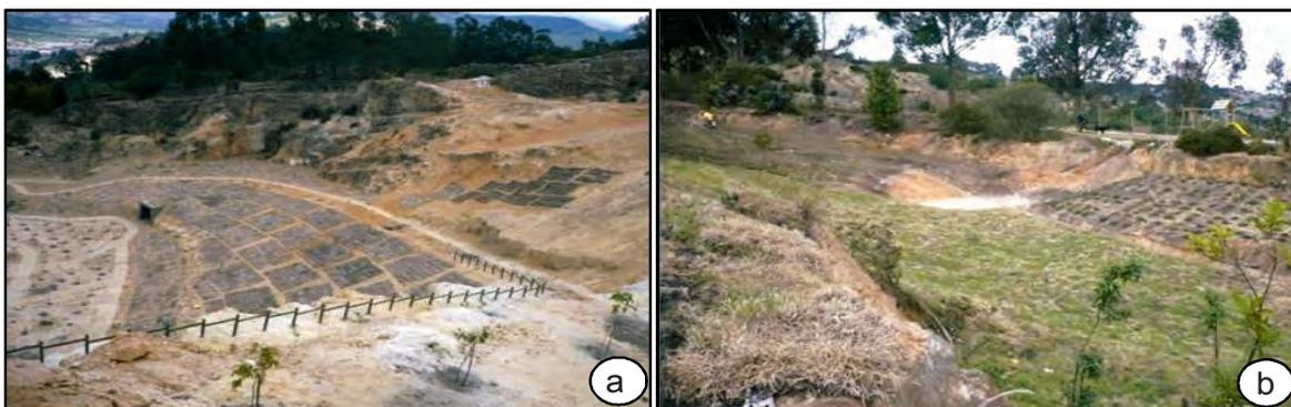
**Figura 5.8** Tratamientos para el recubrimiento vegetal, posterior a la estabilización de taludes y el manejo de aguas, en la cantera Soratama: a) uso de biomantos artesanales, y b) colocación de cespedones de kikuyo y plantación de hierbas y arbustos.
