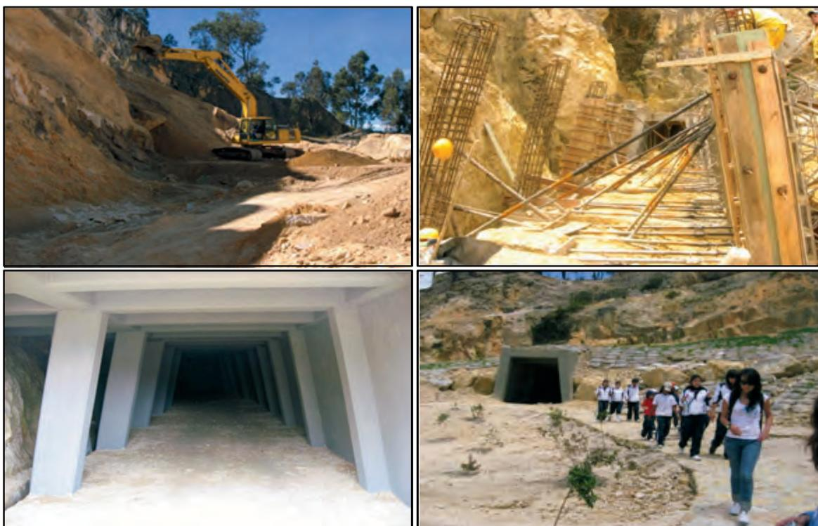
**Figura 7.7** Galería de Drenaje en zona de antiguos taludes de explotación (Fotos: SDA, 2005-2009).
