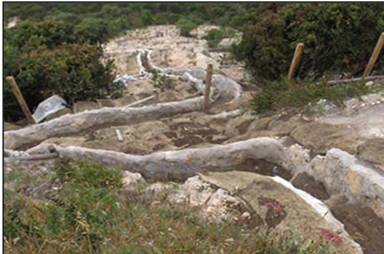
**Figura 6.12** Zanjas escalonadas para desviar el agua en el Aula Ambiental Soratama.
