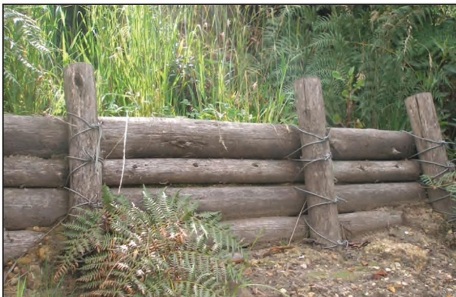
**Figura 6.10** Trinchos colocados transversalmente a la pendiente para controlar el arrastre de materiales en la quebrada de Hoya del Ramo.
