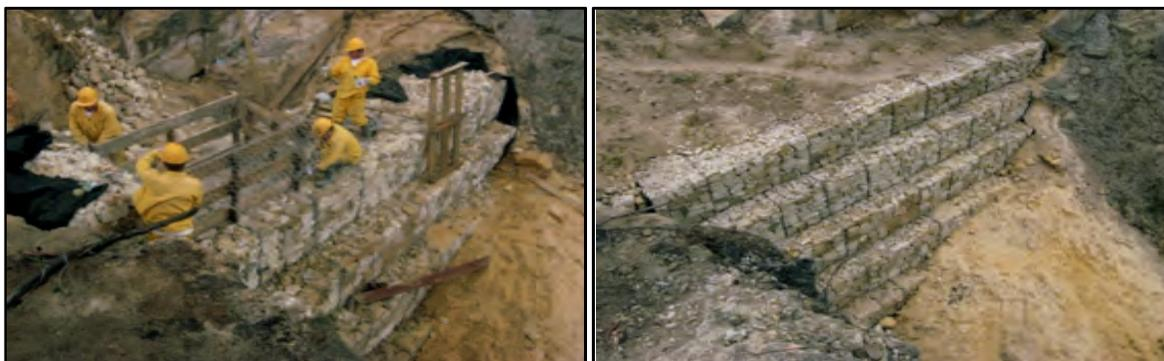
**Figura 7.8** Gaviones el control de erosivos (Fotos: SDA-Unión Temporal 2005; SDA, 2008-2009)
