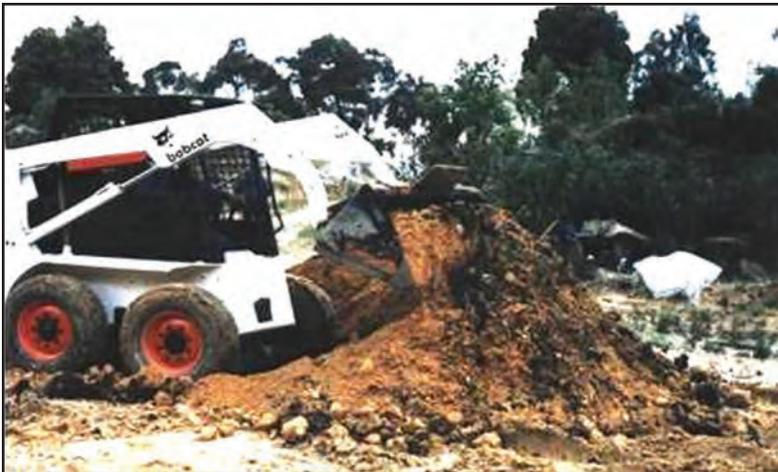
**Figura 5.13** Mezclas de los diferentes tratamientos (biosólidos y estériles) mediante ayuda de un bobcat.
