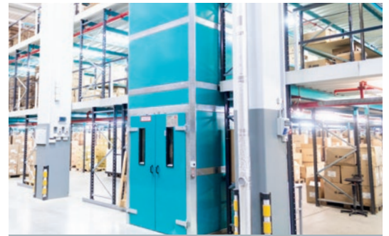
3 | Der GEBHARDT ConVer® 147 Güteraufzug vereint die verschiedenen Ebenen und Arbeitsbereiche.
