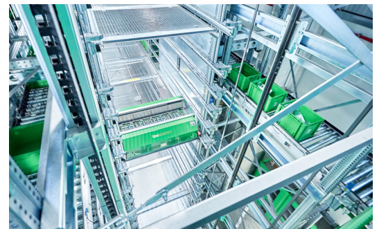
2 | Das dreigassige Shuttlelager mit insgesamt 45 One-Level-Shuttles (OLS).
