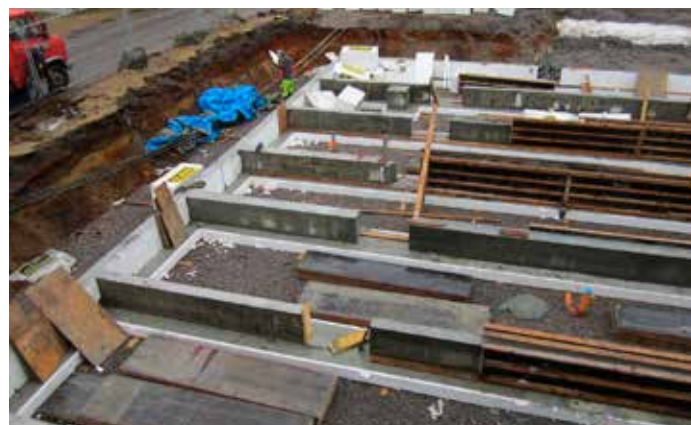
Fundamentene sto ferdige 6. april. Deretter gikk det modul i modul til alle 58 var på plass. FOTO: JAKOB OMMEDAL
