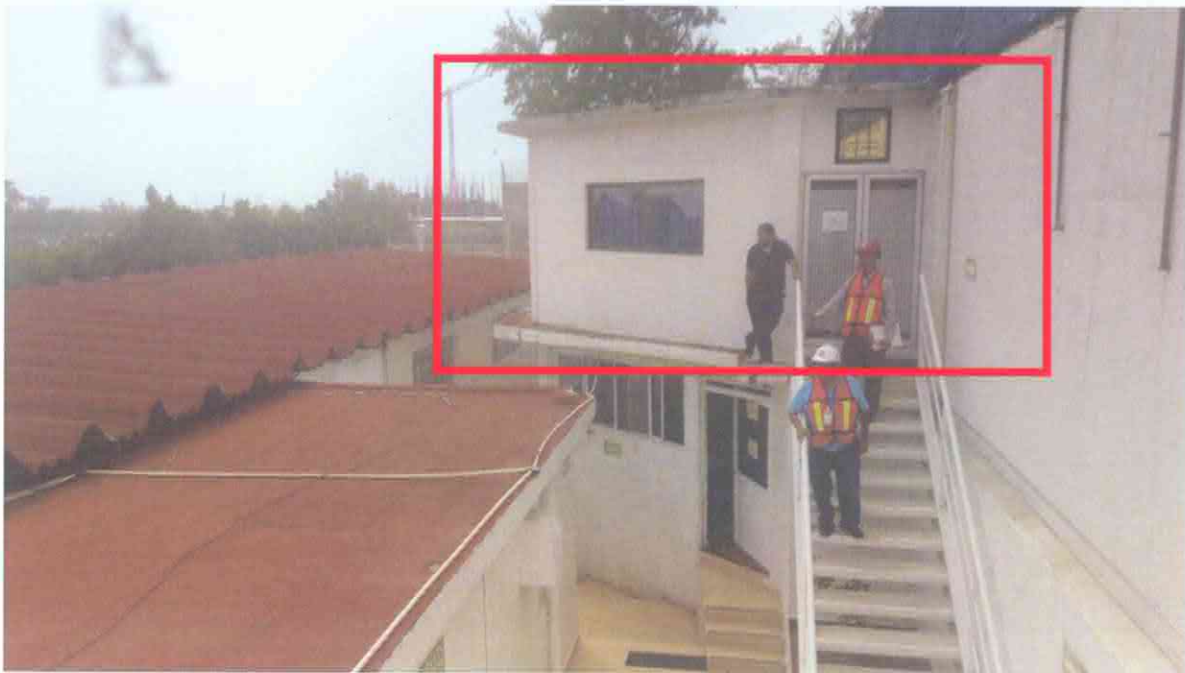
AREA RESTRINGIDA (FUERA DE USO)
