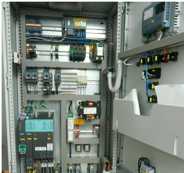
Bild 5: Aufgeräumter Anblick: Alle Schaltschränke werden mit EPLAN Pro Panel geplant
