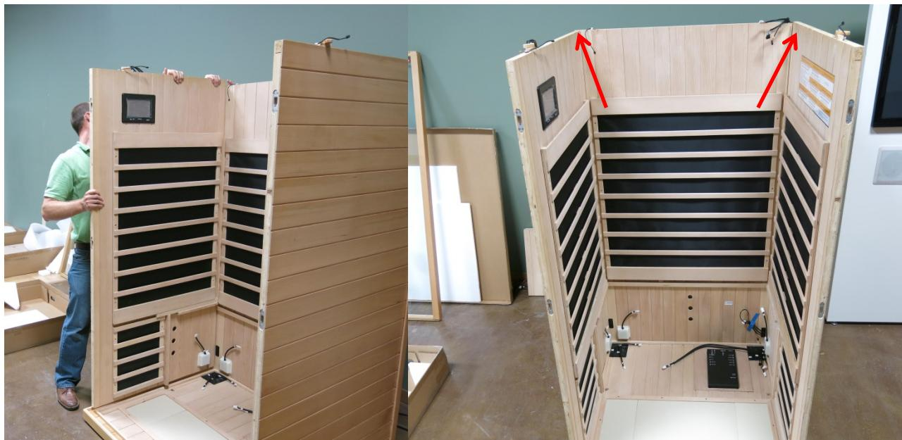
**Примечание. После надлежащего соединения панелей стенок углы сверху будут плоскими – см. рисунок справа сверху. Правая стенка установлена неправильно, а левая – правильно.**
