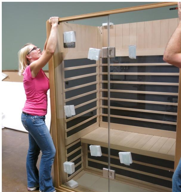
**Примечание. Зафиксируйте дверь для защиты от открытия и поломки при установке панели передней стенки. При опускании панели передней стенки на место можно придержать ее коленями.**
