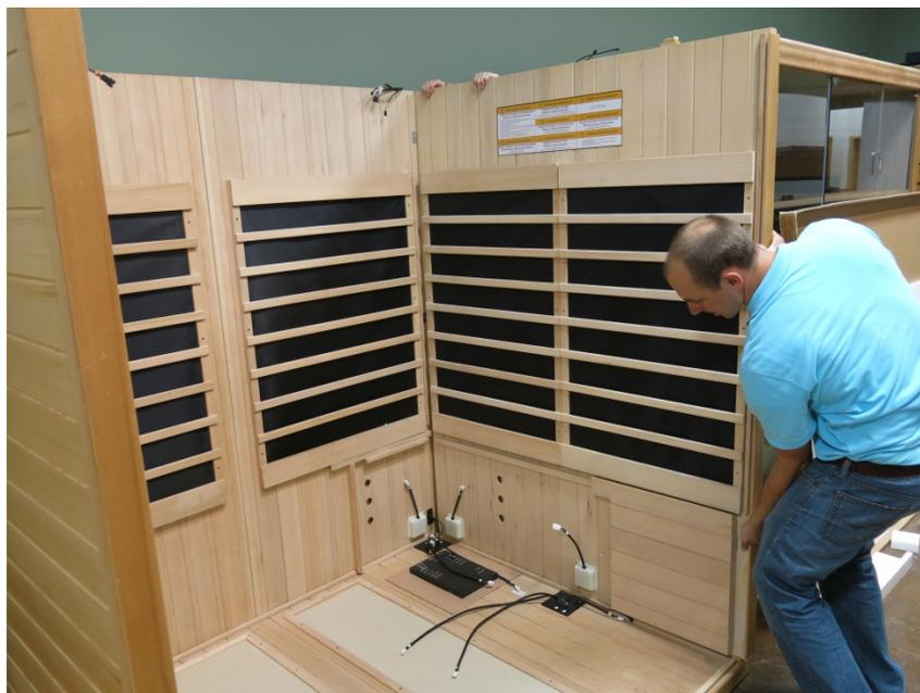
*Примечание. После надлежащего соединения панелей стенок углы сверху будут плоскими. Если одна панель расположена выше другой, она не зафиксирована на месте надлежащим образом или под ней что-то находится.*
