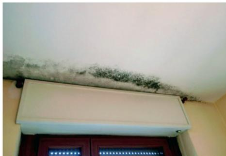
Fig. 2.3 Esempio di muffa che si forma sul soffitto a causa delle basse temperature superficiali dovute alle infiltrazioni d'aria provenienti dal cassonetto dell'avvolgibile non correttamente isolato.
