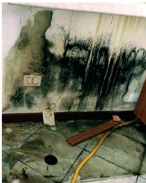
Fig. 1.9 Nelle cucine e nei locali dove l'umidità è molto alta, le muffe si formano soprattutto dietro i mobili e gli armadi e da qui rilasciano continuamente le spore che spesso provocano problemi di salute anche seri agli occupanti.
