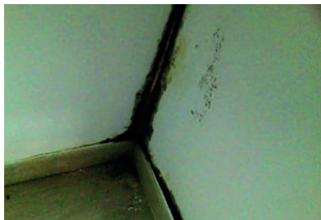
Fig. 114 Nei ponti termici, cioè nelle zone più fredde dell'edificio, facilmente si forma la condensa che a sua volta diventa la causa di sviluppo delle muffe.
