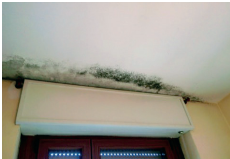
Fig. 1.6 La muffa si forma sul soffitto a causa delle basse temperature superficiali dovute alle infiltrazioni d'aria provenienti dal cassonetto dell'avvolgibile. Essendo disturbate dalle correnti d'aria, preferiscono insediarsi a una certa distanza dalla fonte dello spiffero.
