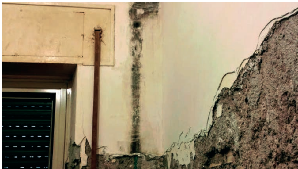
Fig. 1.15 Interessante situazione dove la formazione di muffa è avvenuta in corrispondenza di una tubazione di acqua fredda. Praticamente, l'abbassamento di temperatura localizzato dovuto al flusso di acqua fredda, ha causato la condensa in superficie, sulla quale ha poi attecchito la muffa solo in prossimità dei tubi.
