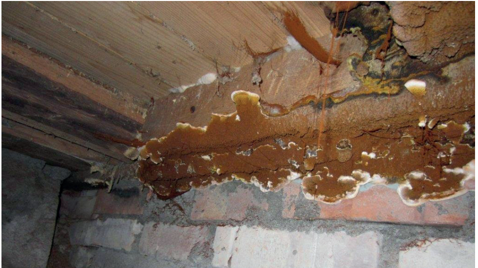
Fig. 1.5 Alcune muffe sono estremamente dannose per gli edifici, e sono in grado di causare dei danni molto seri in tempi brevi. La Serpula lacrymans è un tipo di fungo che aggredisce il legno, comprese le strutture portanti, causandone rapidamente la distruzione.
