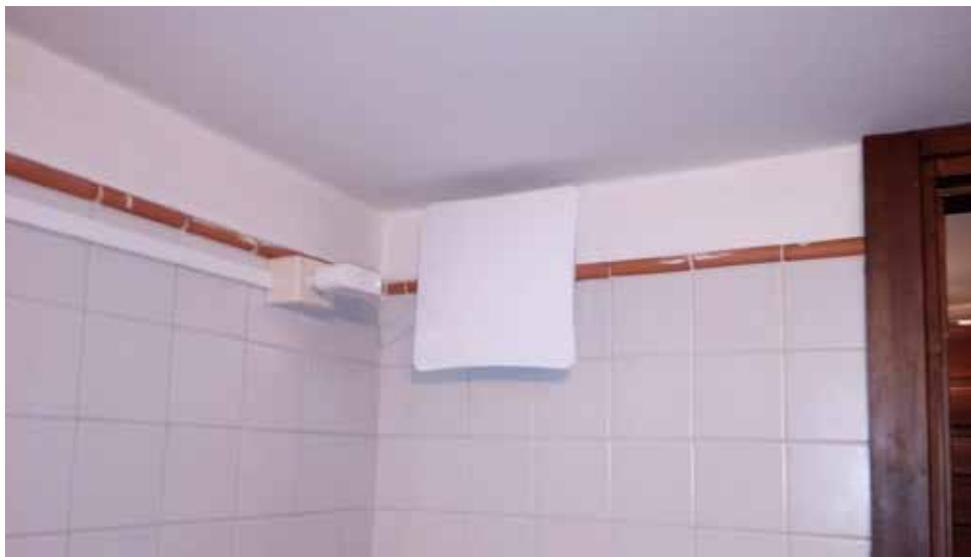
Fig. 12 I sistemi di ventilazione a semplice estrazione sono adatti solo nei locali dove si produce localmente molto vapore come bagni e cucine.
