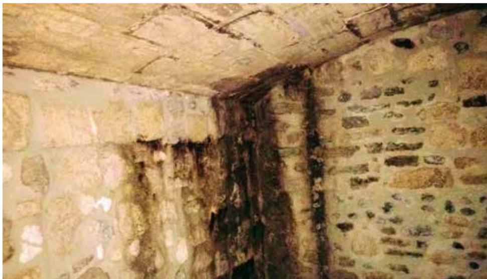
Fig. 2.6 Le muffe possono formarsi facilmente e rapidamente se entrano in contatto con acqua liquida, che solitamente ha origine o condensativa o infiltrativa. Nella foto è visibile una formazione di muffe sulla parete di un locale completamente interrato dove sono in atto delle infiltrazioni provenienti dalla strada retrostante
