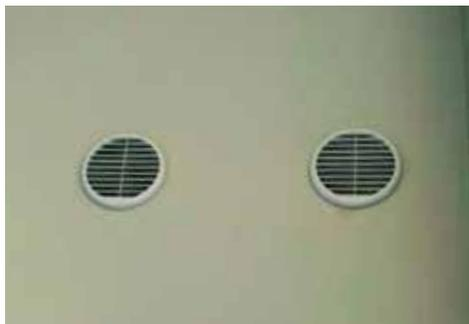
Fig. 10 Spesso si realizzano dei fori sulle pareti sui quali poi vengono installate delle griglie, senza alcun tipo di ventola, con l'intenzione di assicurare un adeguato ricambio d'aria. Nella realtà la quantità d'aria che può passare attraverso queste prese d'aria statiche in maniera naturale senza che venga spinta da un'elettroventola è molto bassa e difficilmente può soddisfare le aspettative del cliente.
