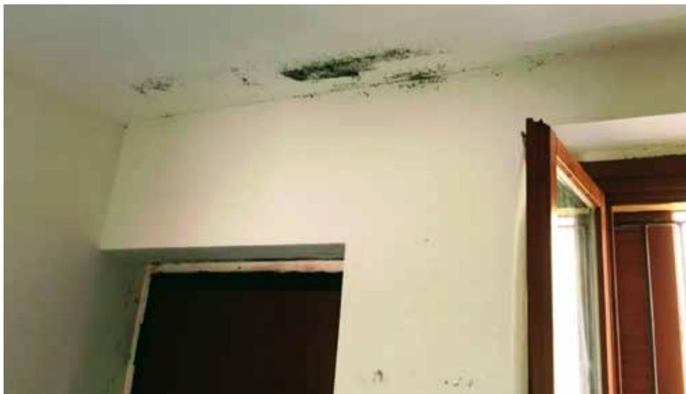
Fig. 11 Affidare alla sola apertura delle finestre la funzione del ricambio d'aria può non essere sufficiente. In questo caso l'edificio si affaccia direttamente sulla strada e l'apertura della finestra comporta oltre all'ingresso dell'aria anche quello del rumore, perciò viene mantenuta aperta per intervalli molto brevi e poco frequenti che si sono dimostrati insufficienti.
