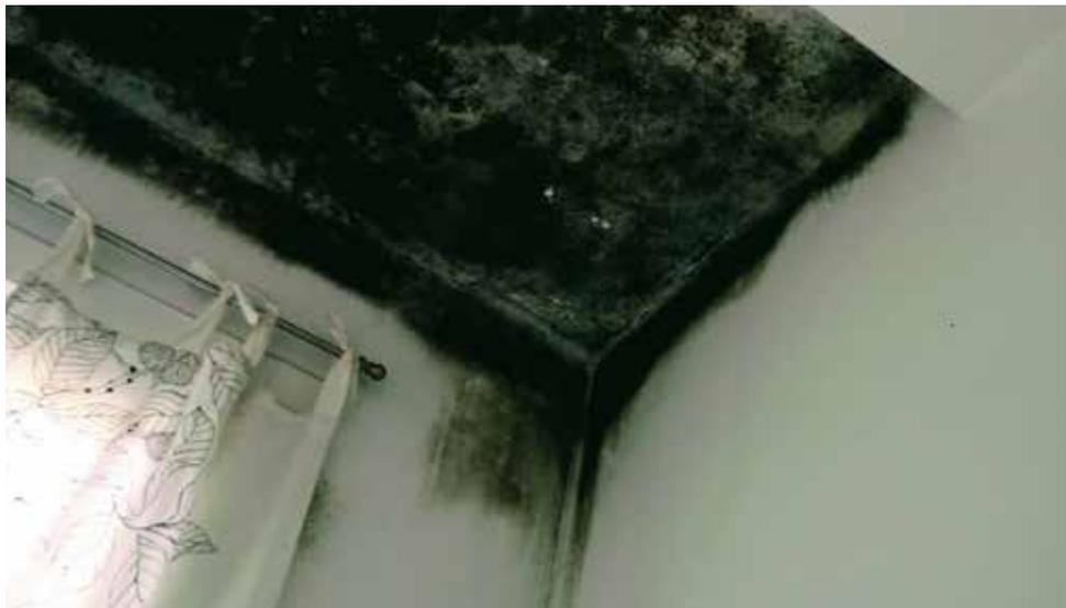
Fig. 2.7 In molti casi le formazioni di muffa sono dovute alla combinazione di fattori derivanti dall'edificio e dalle modalit  con cui questo viene utilizzato e gestito. Nella foto si osserva una massiccia presenza di muffe nere, probabilmente *Aspergillus* dovute alla bassa temperatura delle superfici che sono la causa di condense, unite a una scarsa manutenzione.
