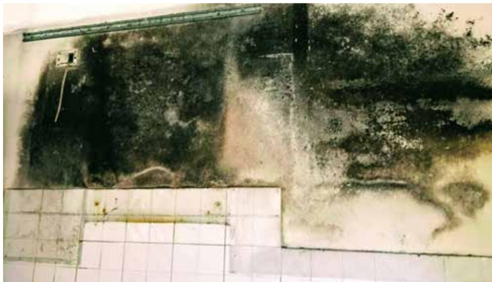
Fig. 2.5 Le muffe molto spesso si nascondono nelle zone non illuminate e non ventilate, dove possono svilupparsi indisturbate.
