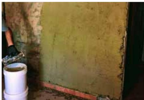
Fig. 15 Realizzazione di un intonaco di argilla.
