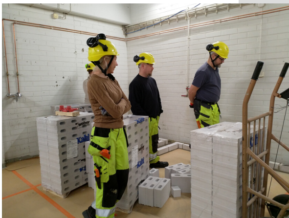
Hyrian opiskelijaryhmä valmiina harjoittelemaan muuraustyötä CAMU 1200 -kohdepoistolaitteen kanssa.
