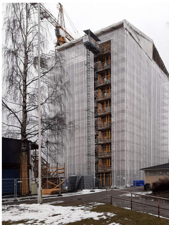
Niiralan Kulma, Raviradantie 8, Kuopio Kuva Harri Lyytinen, Rakennusliike Kuoma Oy
