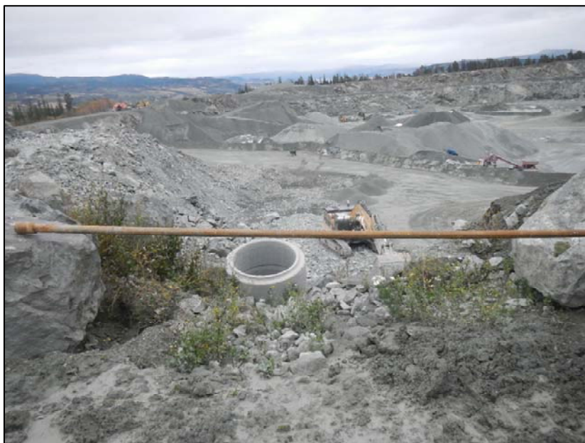
Figur 3 Prøvetakingskum for P5 ble satt ut av drift i oktober 2015.
