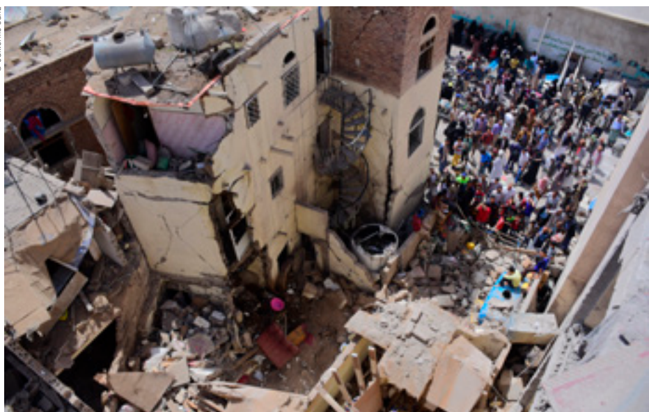
Diversos habitatges van quedar destruïts pels atacs aeris a Sanà, la capital del Iemen, el dijous 16 de maig del 2019.
