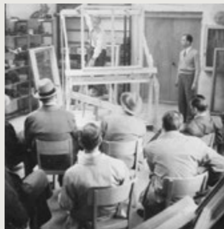
Nel 1948, il laboratorio dimostrativo a Søborg, per la Commissione Edilizia di Copenhagen
