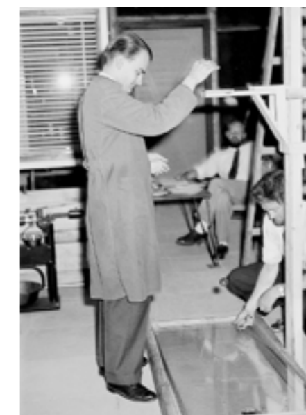
Hans Niels Brandt, incaricato per lo sviluppo del brand VITRAL, è qui ripreso mentre prova la durezza delle lastre, lanciando sfere metalliche sul vetro. La foto risale all'incirca al giugno del 1959. La data esatta della foto non è nota
