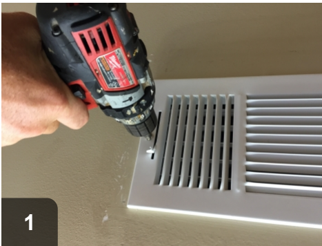
1 Remove diffuser
