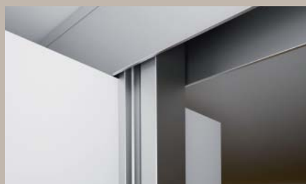
Die Oberkante des Regals schließt mit der Führungsschiene ab.
