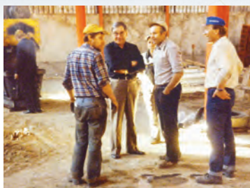
Kiikoisten tehdas rakennusvaiheessa
