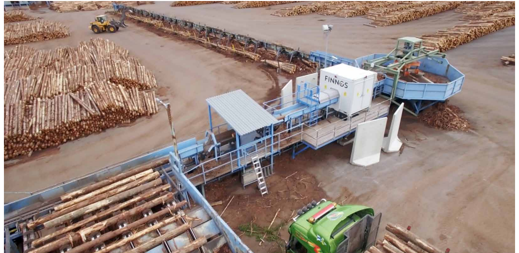
▲ Mustola Timber Oy:n mittauskuljetinta modifioidaan, jonka jälkeen tukkimittarista saatava hyöty kasvaa entisestään.
