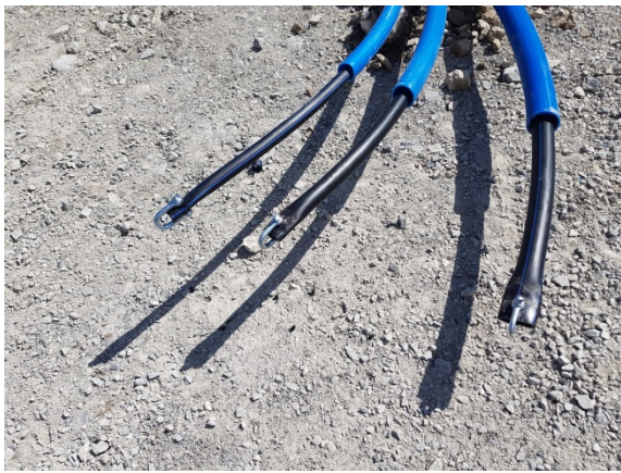
Bilde 2 – Sjakler festet til enden på PE-ledninger før uttrekking.
