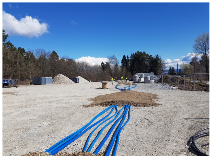
Bilde 1- Testområde på Vakås. Vannledningene klarlagt for uttrekking. dato 26.04.2018.
