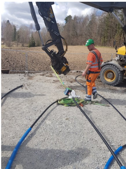
Bilde 4 – Uttrekking gjennomføres med gravemaskin.
