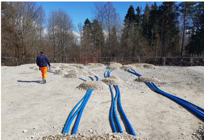
Bilde 7 – Punktbelastning av pukk ved avvikling på vannledningene.
