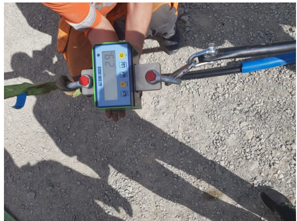
Bilde 3 – Trekkrefter registreres ved uttrekking.
