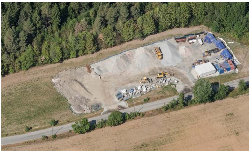
Bilde 5 – Riggområdet sett fra luften.
