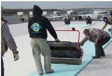
Para aplicar el adhesivo, utilice rodillos de pelo mediano (3/8") que sean resistentes a los solventes. Por lo general, los rodillos con pelo de 3/8" son adecuados para adhesivos a base de agua o solvente. Todos los rodillos deben mantenerse limpios y libres de adhesivo curado.
