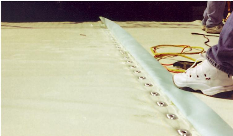
Un Rollo Top-Sider Estándar para el Sistema de Recubrimientos para Techos FiberTite mide 20’ de ancho x 86.7’ de longitud y tiene un rendimiento bruto de 1,734 pies cuadrados.
