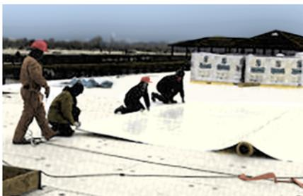
Jale la lengüeta hacia abajo hasta que quede ajustada e instale los sujetadores y las placas de sujeción según las especificaciones del proyecto.
