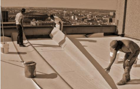
Doble la parte del traslape que "conforma la parte inferior" y colóquela primero en el adhesivo.
