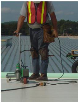
8. Siempre asegúrese de que una pequeña gota del compuesto KEE fluya del extremo de la membrana por debajo de la rueda de prensado durante el proceso de soldadura.
