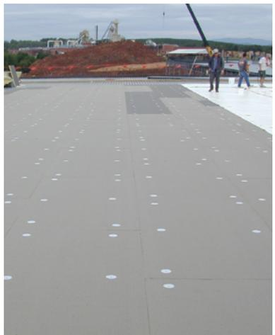
No instale más aislamiento del que pueda cubrir con el [Sistema de Recubrimientos para Techos FiberTite](#) (fijado y sellado) en un día de trabajo.
