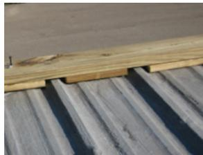
Bajo cualquier condición, la sujeción horizontal y vertical debe proveer una resistencia mínima a la extracción de **300 libras** por pie lineal.
