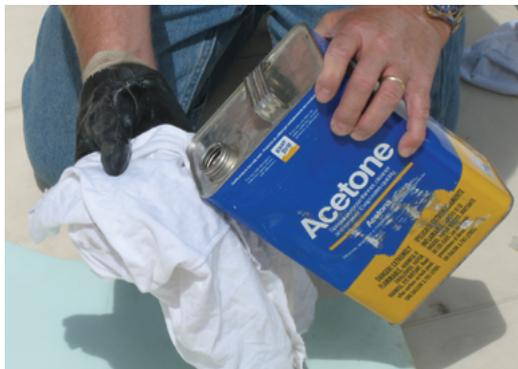
5. Limpie la superficie de la membrana (y la parte posterior de la membrana que se utilizará como parche) un mínimo de 2" alrededor del área dañada (y del área del parche) utilizando un paño de algodón blanco y **acetona** o **metiletilcetona (MEK)**.
