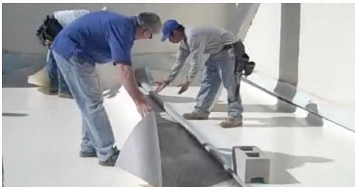
El tiempo de pegado (tiempo abierto) del adhesivo varía dependiendo de la temperatura y se limita a un máximo de 10 minutos, pero es recomendable colocar la membrana con revestimiento de vellón lo más pronto posible después de aplicar la espuma.
