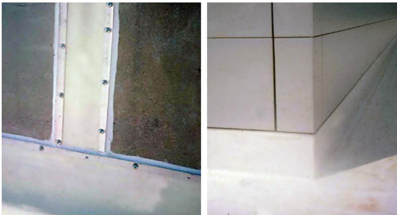
1. En las terminaciones expuestas de los tapajuntas, cerciórese de aplicar una gota continua de sellador entre el muro y la membrana tapajuntas **FTR** directamente detrás de la barra de terminación para proveer un sello de compresión adecuado.
