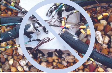
Se debe hacer todo lo posible por evitar el uso de bandejas tapajuntas, incluyendo la remoción de las bandejas existentes. Póngase en contacto con el **Departamento Técnico de FiberTite** para conocer las recomendaciones específicas.
