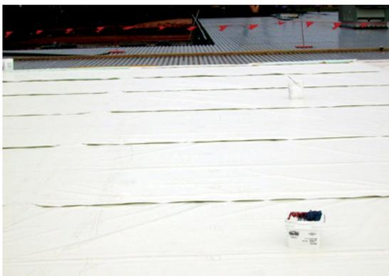
Los rollos subsiguientes se instalan con un traslape nominal de 5". Cada rollo personalizado de 20' x 70.5' requiere de aproximadamente 250 pies lineales de soldadura térmica realizada en campo y solamente 39 pies cuadrados de traslape durante su instalación.
