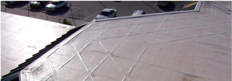
En caso de que sí sea necesario utilizar las tiras de tormenta, los intervalos recomendados y la separación de los sujetadores se basarán en los valores de elevación en campo, según se indica a continuación:
