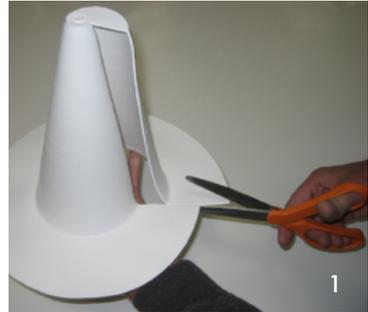
2. Recorte la parte superior del tapajuntas, cortando por el gradiente correspondiente al diámetro de la tubería. »
