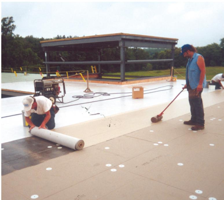
Por último, las membranas con revestimiento estilo SM (FiberTite-SM y FiberTite-XTreme) pueden utilizarse con el adhesivo FTR 490 mediante una aplicación en un lado sobre el sustrato solamente. El adhesivo se aplica al sustrato y la membrana se desenrolla en el adhesivo húmedo.
