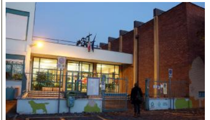
L'ingresso della scuola primaria «Torricella»
