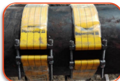
Kaldreparasjon av rør
