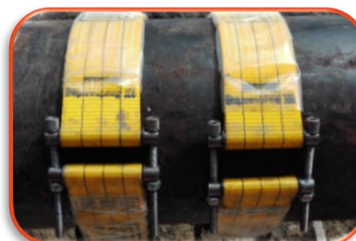
Kaldreparasjon av rør
