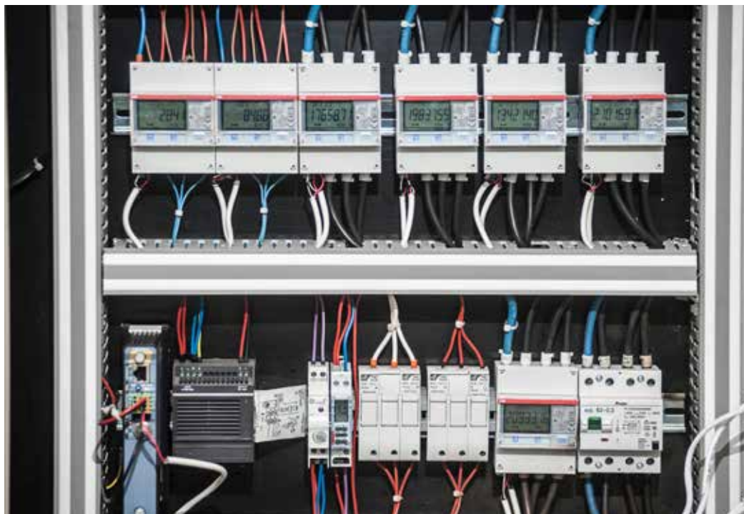
Deze energiemeters en energieregistratiesystemen zorgen ervoor dat het verbruik van de verlichting nauwkeurig opgevolgd kan worden.
