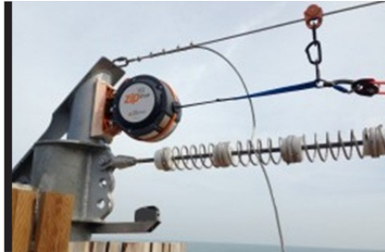
Federpaket-Bremse
