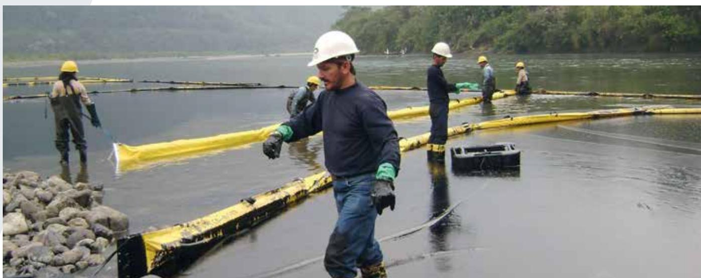
Schaumgefüllte Rundkörper-Ölsperre SFB, Höhe: 360 bis 920 mm
