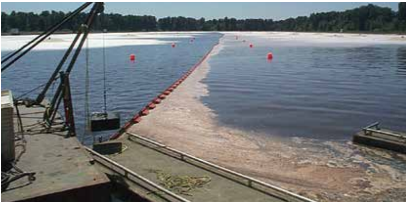
نظام الحواجز (Baffle System)
