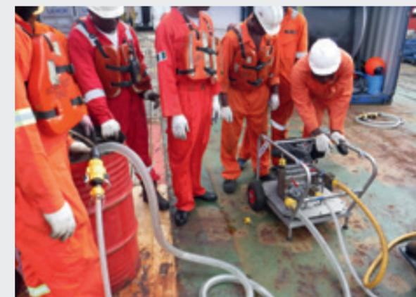
Развертывание системы нанесения диспергентов с борта судна
