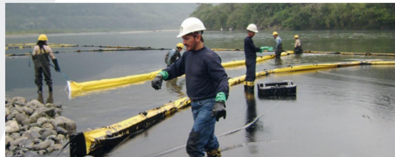
Боны постоянной плавучести, высота от 360 до 920 мм
