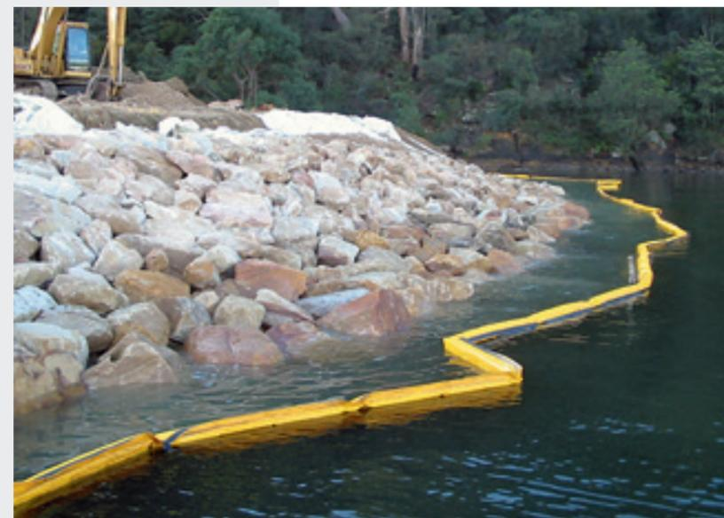
Перегорodka-занавес от грунтовых загрязнений Silt Curtains
